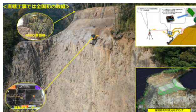
図表18 急斜面法面掘削機によるICT施工
