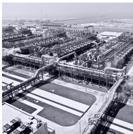
<タワーラ発電造水プラント(アブダビ)>
