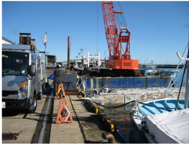
図表 3-2-39 羅臼漁港岸壁耐震改良工事
