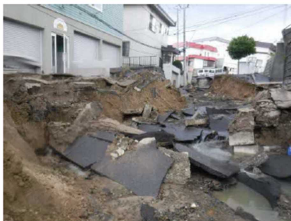
札幌市清田区（道路損壊）
