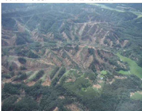
厚真町 厚幌ダム上流（山腹崩壊）
