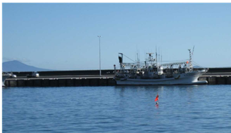
図表 3-2-38 耐震強化岸壁
