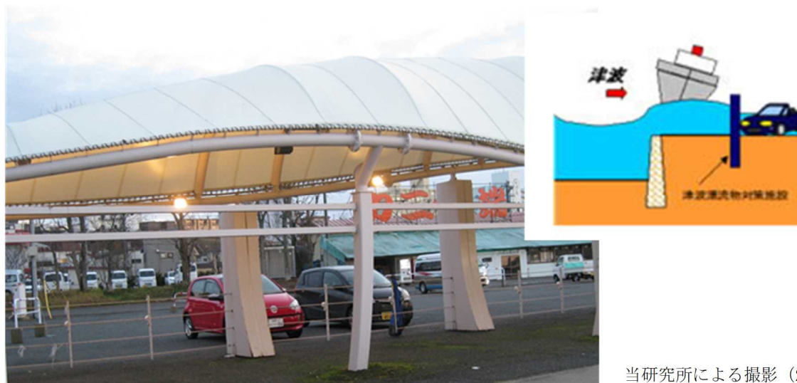
図表 3-2-26 津波スクリーン（左）と防災イメージ（右）
