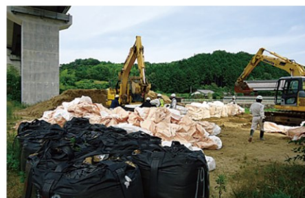
大型土のう製作支援状況【7月13日撮影】
