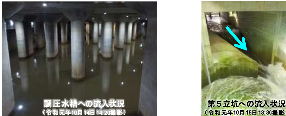
図表 1-5-28 首都圏外郭放水路の稼働状況（台風第19号）
