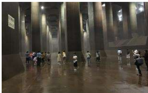
【調圧水槽の内部】
