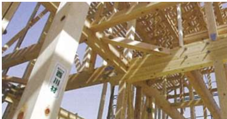
図表 2-3-10 西川材を用いた躯体
