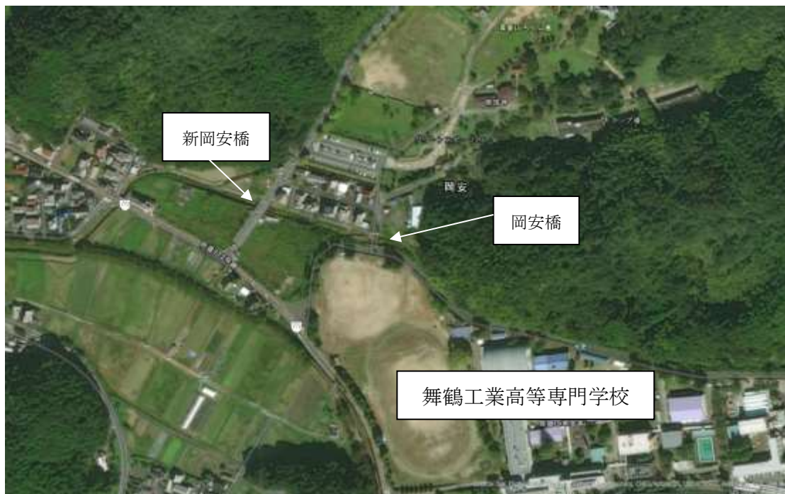
図表 1-4-21 岡安橋付近 航空写真
