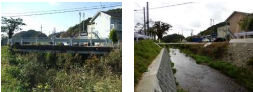
図表 1-4-24 撤去前の吉坂橋（左）と撤去後の現況（右）
