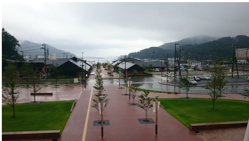
図表 17 女川駅構内よりプロムナードを撮影
