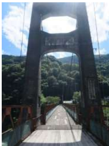
図表 1-4-12 大川橋の現況
