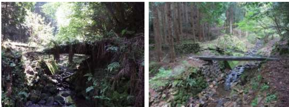
図表 1-4-19 豊岡市による架替前（左）と架替後（右）の滝山橋
