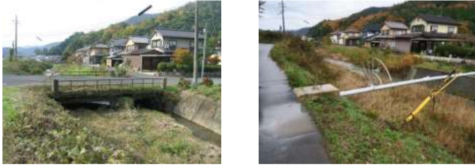
図表 1-4-22 撤去前の岡安橋（左）と撤去後の現況（右）
