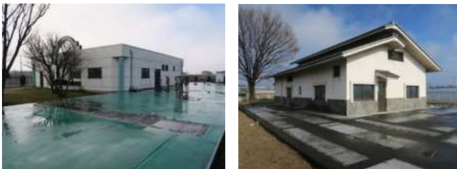
図表 1-4-31 赤堀今井地区処理施設（左）、赤堀西部地区処理施設（右）の廃止後の現況
