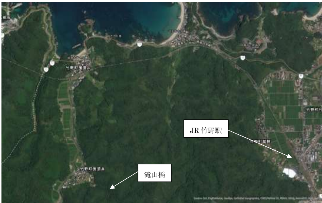
図表 1-4-16 滝山橋付近 航空写真
