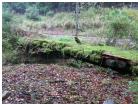
図表 1-4-17 491 橋の現況
