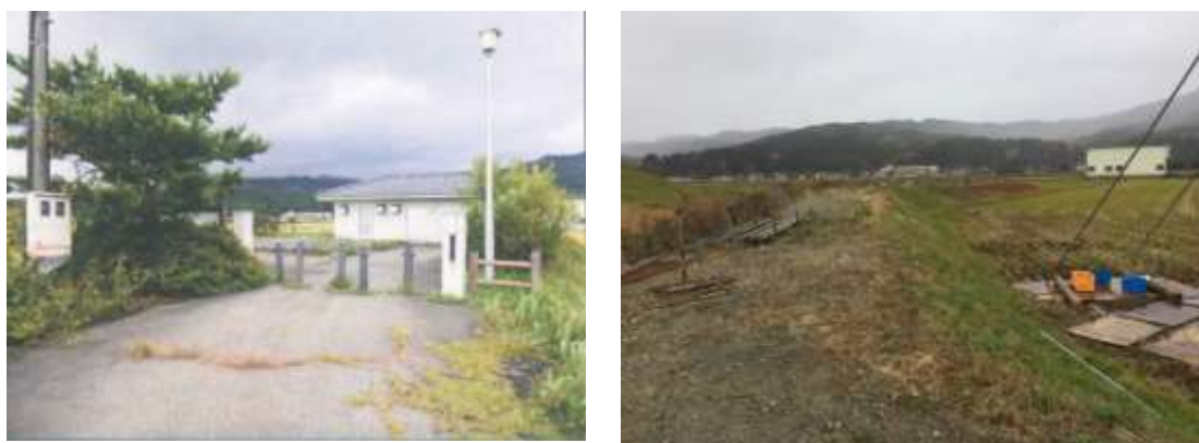
図表 1-4-27 撤去前の大川渡処理施設（左）と撤去後の現況（右）
