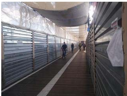
ブルックリン橋・補修工事のため養生中
